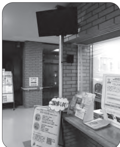
サーモグラフィーを設置しました
